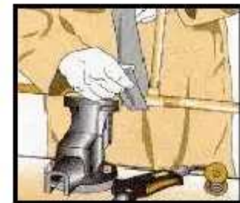
Dejar que se enfríe la soldadura y limpiar los residuos.
