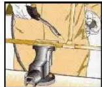
Aplicar calor con la lamparilla a las juntas a soldar.
