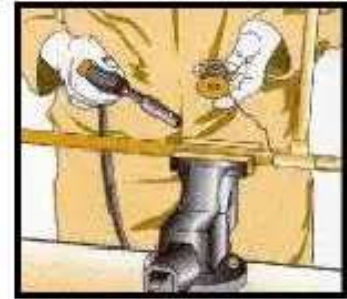
Una vez calientes las juntas arrimar el estaño, comprobando que corre por toda la junta.
